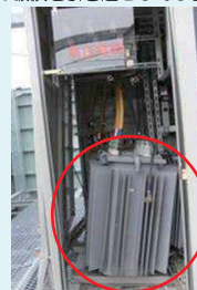
地震の衝撃によりトランスが側面に衝突し、側板と側面扉が変形
