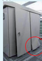
地震の衝撃によりトランスが側面に衝突し、側板と側面扉が変形
