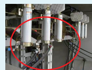
地震によりLBS端子部変形
